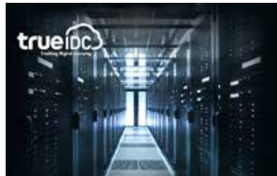
การเปลี่ยนเครื่องสำรองไฟฟ้า เพิ่มประสิทธิภาพพลังงาน บริษัท ทรู อินเทอร์เน็ต ดาต้า เซ็นเตอร์ จำกัด ศูนย์รัชดา
