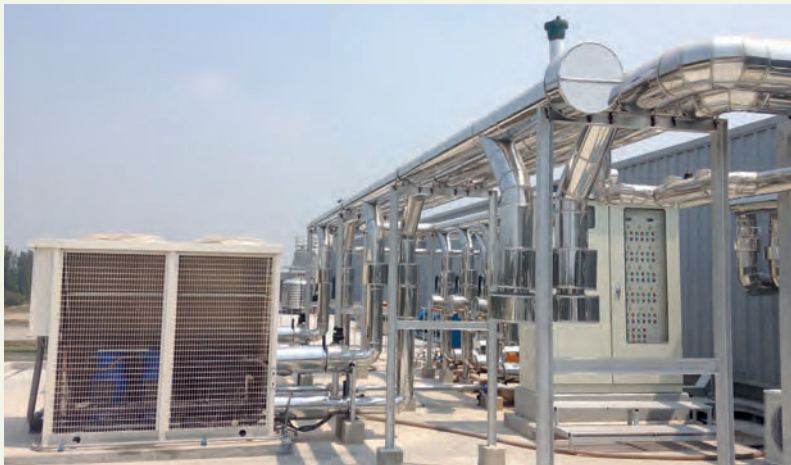
ระบบลดน้ำเย็นแบบระบายความร้อนด้วยอากาศประสิทธิภาพสูง ติดตั้งใช้แทนที่บว. เจริญโภคภัณฑ์อาหาร ศูนย์กระจายสินค้า บานน้ำเปรี้ยว จ.ฉะเชิงเทรา
