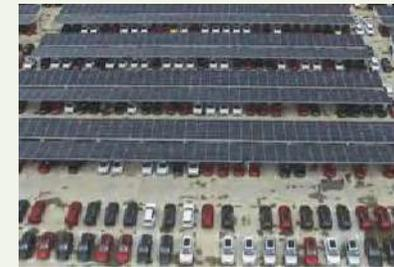
上汽正大有限公司(SAIC Motor-CP Co., Ltd.)建立了泰国最大的太阳能停车场，覆盖面积达3.1万平方米，总生产能力达4.88千瓦。
