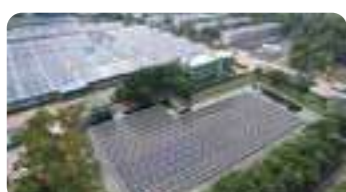
แผงโซลาร์บนหลังคา 4 MW, 1 ไร่ 3,256 ตัน CO 2 e
